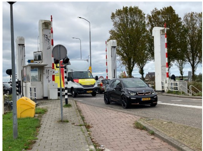
De Bernardbrug zal in de toekomst worden vervangen
