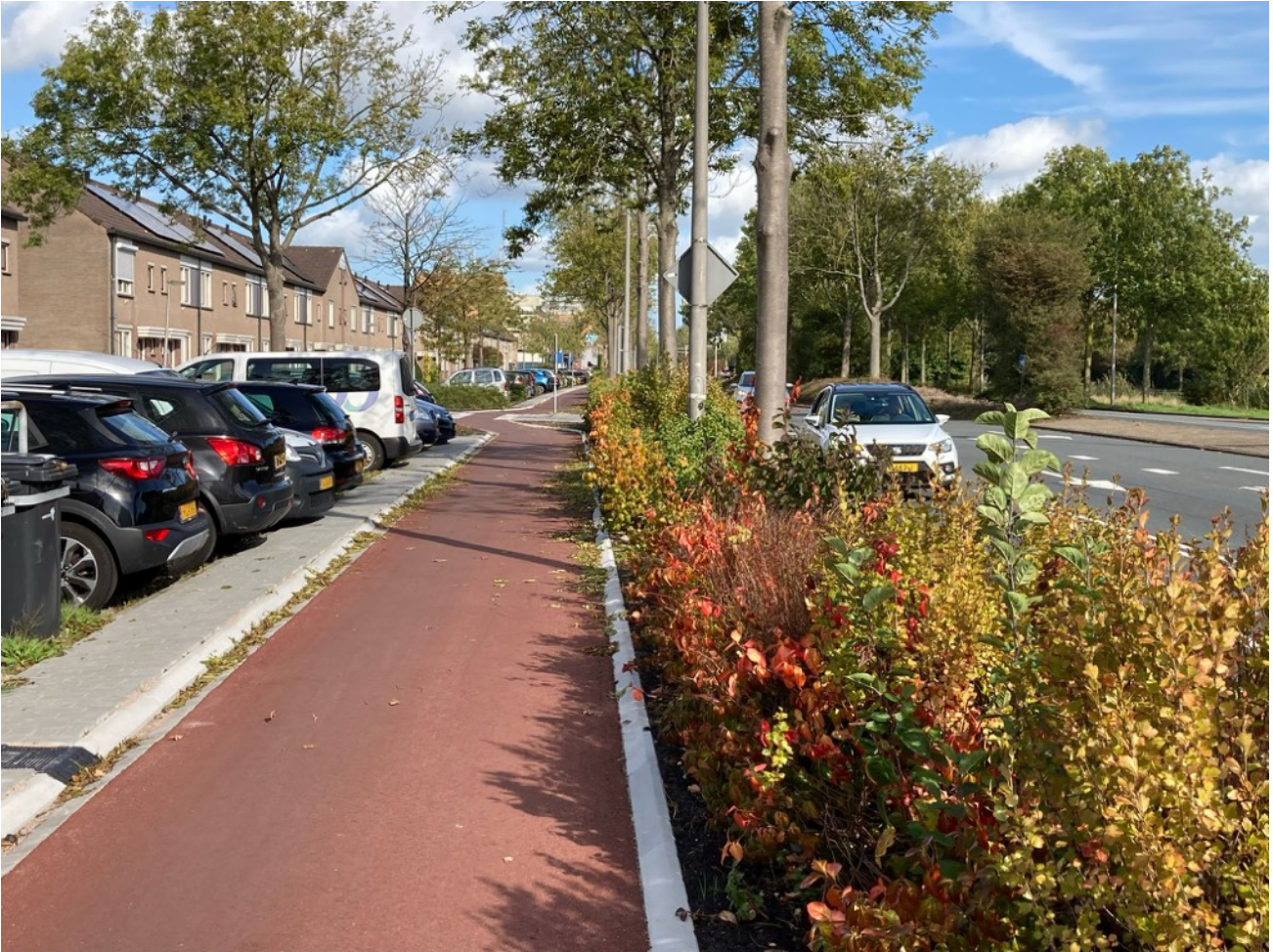
Het fietspad langs Gorslaan is in een nieuw jasje gestoken
